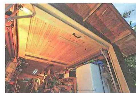
工房の前面ドアは自作のオーバーヘッドスライダーが取り付けられている(開けたシャッターを下から見た状態)
