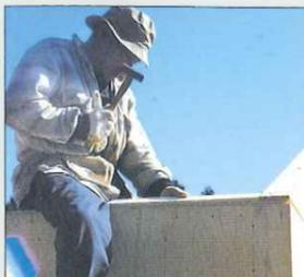
屋根トラスを、壁パネルの上に設置します。
